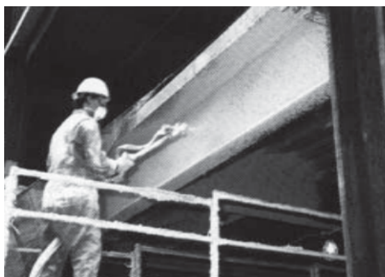
Figura G.0.12 – Aplicação de argamassa projetada
