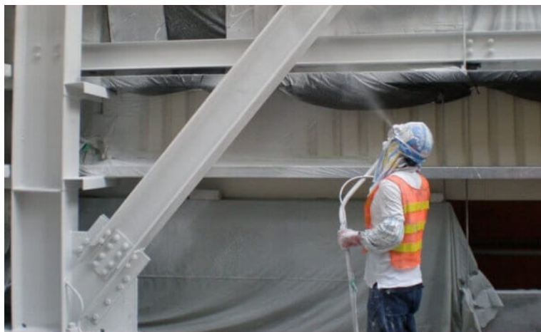
Figura G.0.13 – Aplicação da tinta intumescente
