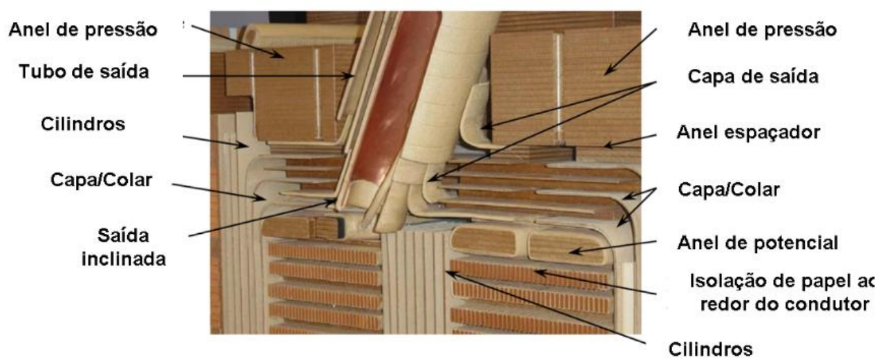
Figura 2.4. Detalhes da isolação entre enrolamentos e terra.
