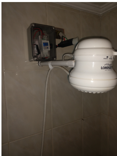
Figura 15 – Instalação do medidor de energia na carga Chuveiro Quadro de entrada da instalação
