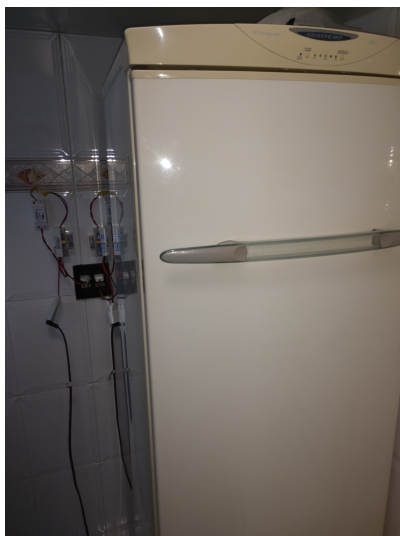
Figura 17 – Instalação do medidor de energia na carga Geladeira
