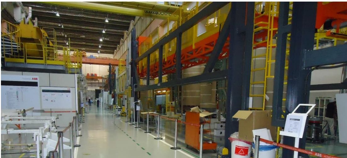
Figura 4.12 – Vista do setor de montagem da parte ativa
