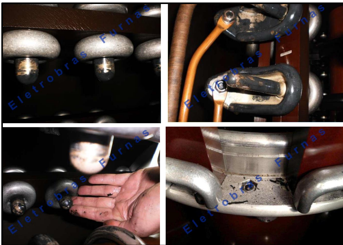
Figura 5.28 Contatos prateados com camada enegrecida e constatação de pouca aderência da camada enegrecida (CRUZ, 2014)
