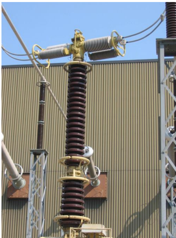
(a) Chave rápida com aneis anti-corona
