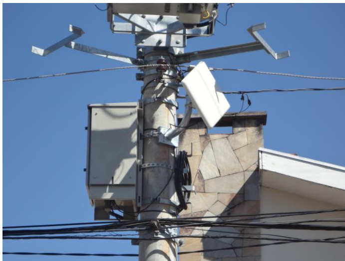
Figura 4 - Montagem no poste de um religador.
