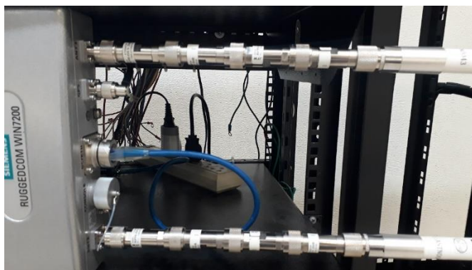
Figura 42 - Montagem do Atenuadores.
