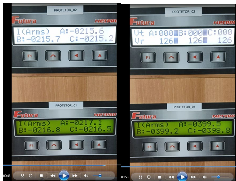
Figura 38 - Momento no qual é emulada uma falha no primário do alimentador do Protetor_02 que provocou uma corrente reversa maior que os 15A do setup do relé, mantida e sem interrupção de uma GD de 400A trifásica
