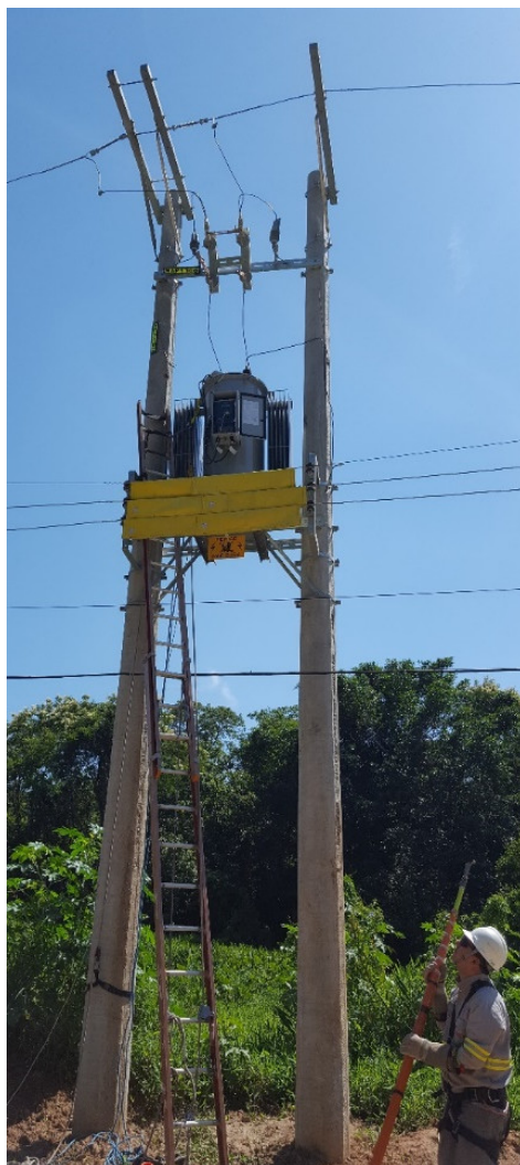
Figura 33 - Instalação em campo do protótipo do regulador indutivo
