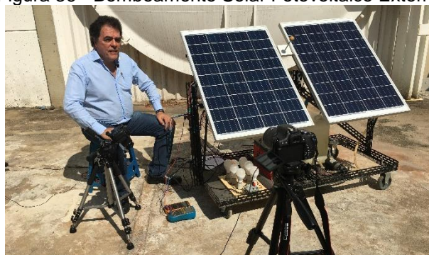
Figura 36 - Bombeamento Solar Fotovoltaico Externo
