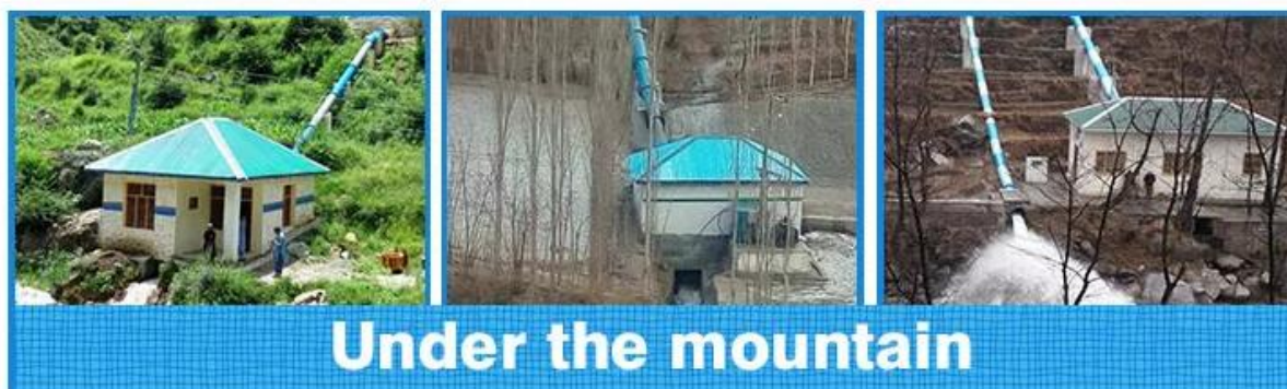
Figura 18: Exemplo de aplicação do grupo turbina-gerador em um sistema isolado. Fonte: (ALIBABA, 2022a)
