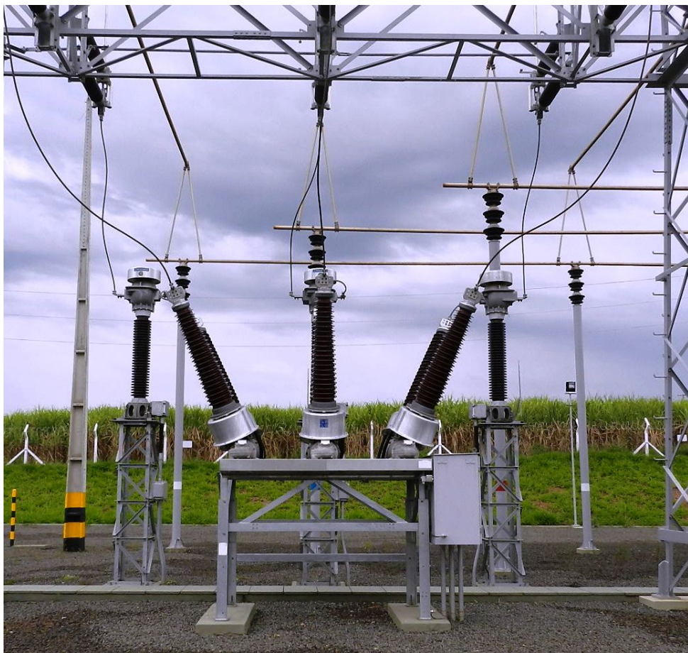
Figura 3: Exemplo - Disjuntor tipo tanque-morto
