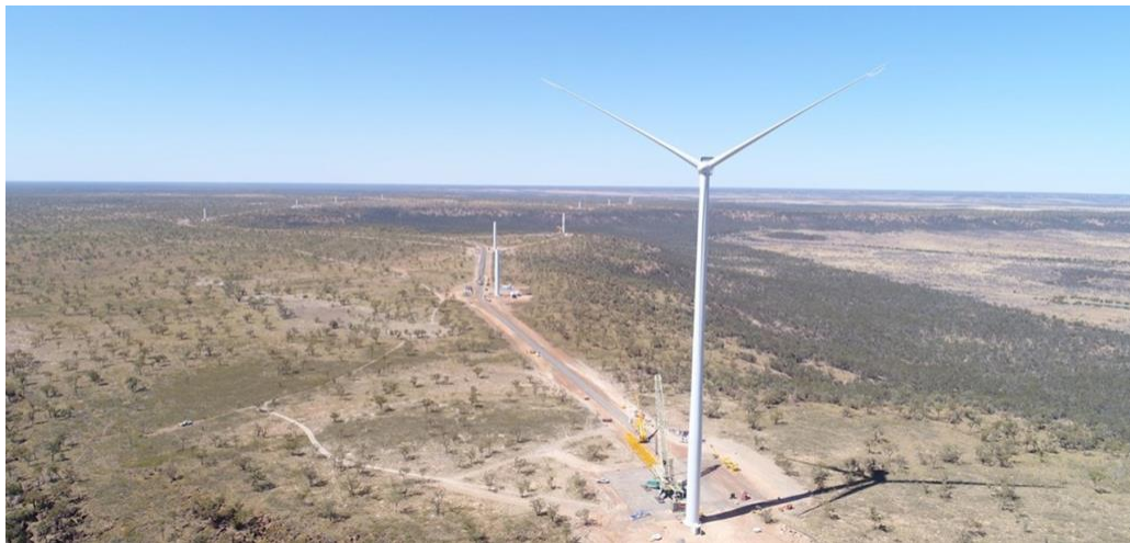
Figura 16 — Usina híbrida de Kennedy Energy Park
