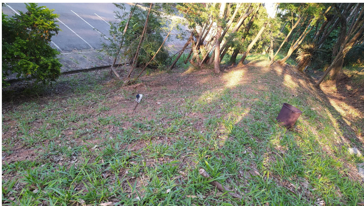
Figura 32: Talude de corte utilizado para simulação de fluxos de detritos.
