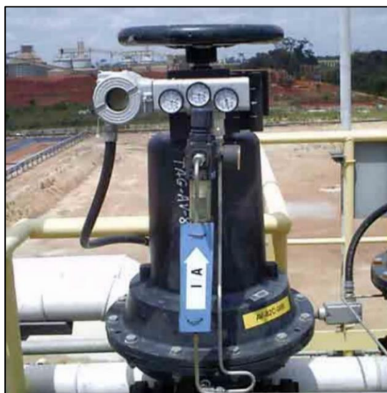
Fig. 3.11 - Exemplo de instalação de um posicionador em campo.
