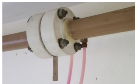
Figura 8 - Placa de orifício entre os flanges com tomadas de pressão
