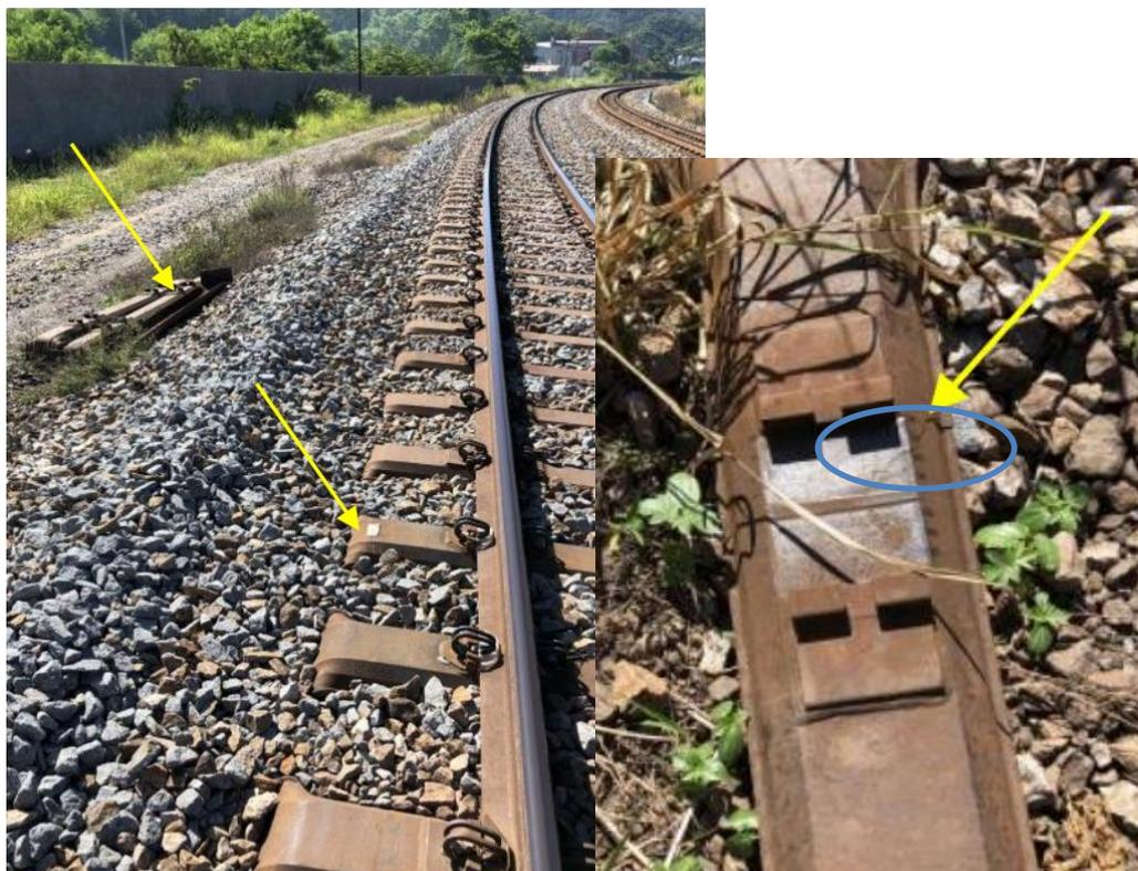
Figura 59 - Identificado a troca recente de dormente quebrado no elemento Curva 2 para o Trecho 1 durante a inspeção de campo de outubro
