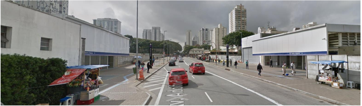
Figura 13 – Estação Adolfo Pinheiro – Linha 5 Lilás.
