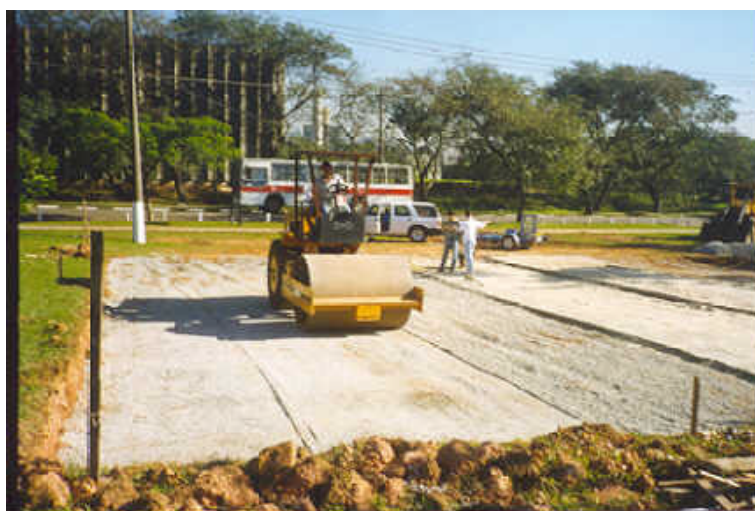
Foto 6.5 Compactação da BGS
