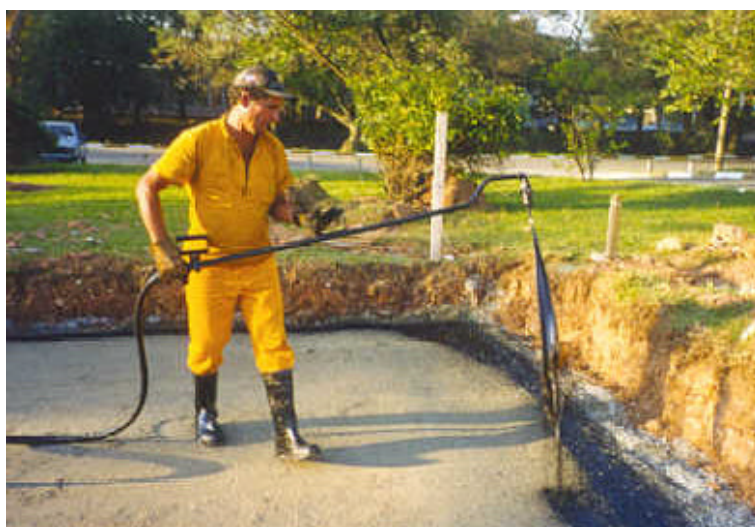
Foto 6.6 Aplicação da imprimação impermeabilizante na BGS
