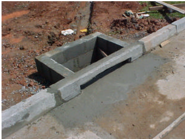
Foto 6.16 Execução de boca de lobo
