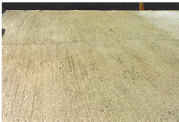
Foto 6.12 Detalhe da textura do pavimento acabado
