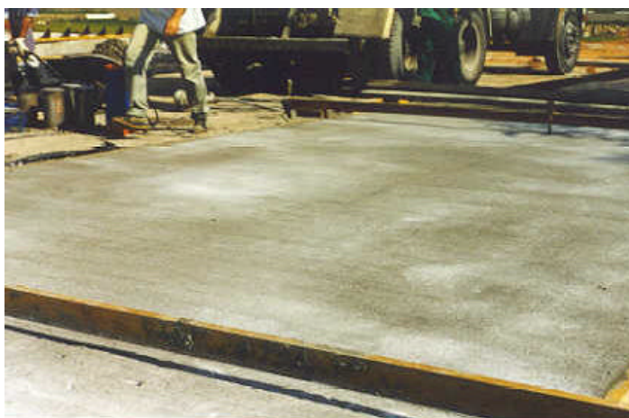
Foto 6.11 Aplicação de produto de cura anti-sol
