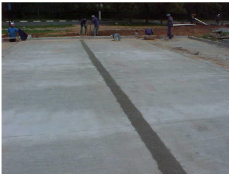
Foto 6.14 Detalhe das cunhas para fechamento das canaletas
