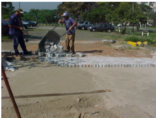
Foto 6.17 Execução do acesso a pista experimental
