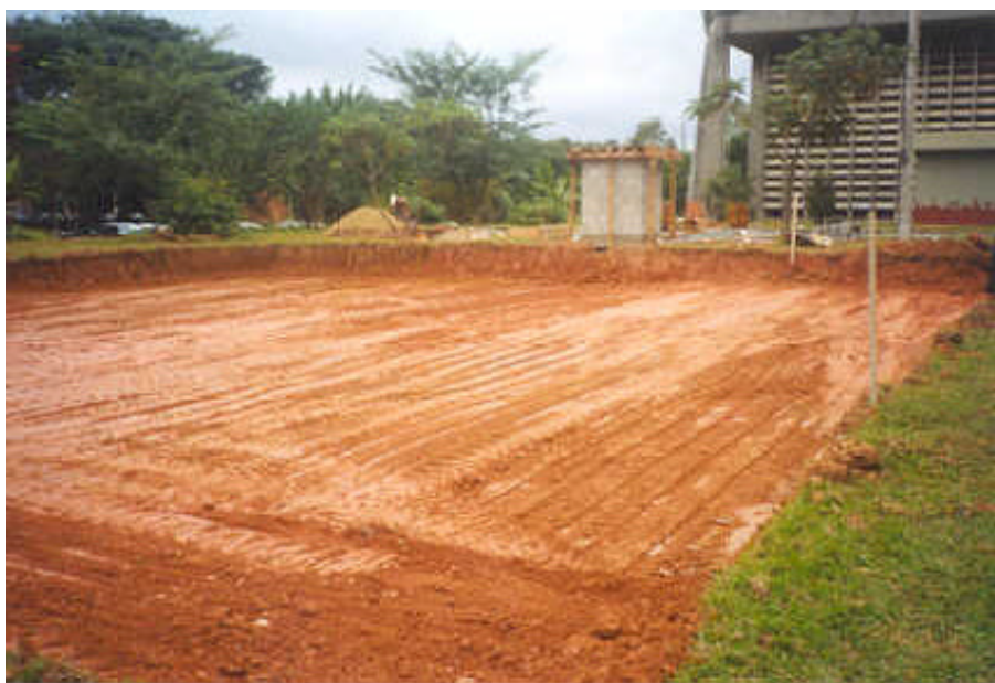
Foto 6.1 Terraplenagem e estação de coleta
