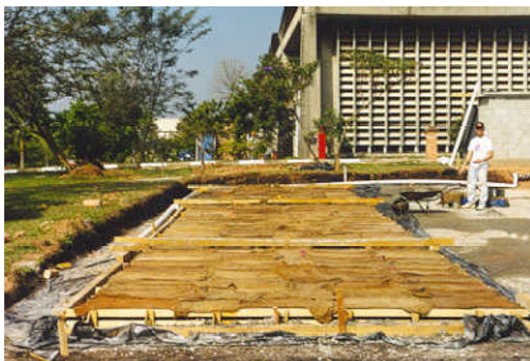
Foto 6.13 Cura do concreto da seção A
