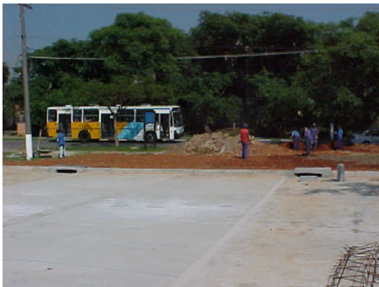
Foto 6.18 Vista da pista experimental acabada
