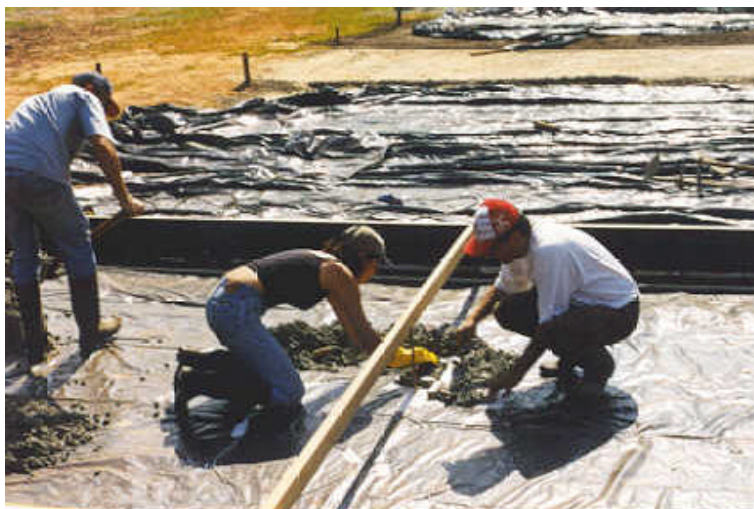
Foto 6.9 Detalhe do sepultamento dos termoresistores (PT-100) e strain gages
