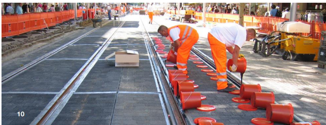
Figura 9: Sistema Edilon Sedra – Aplicação da resina polimérica. Fonte: Edilon Sedra
