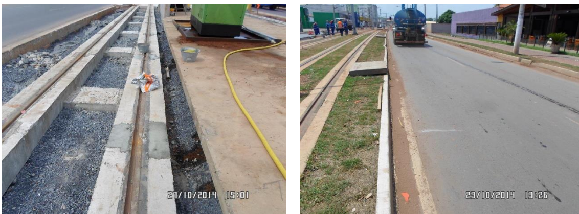
Figura 7: Sistema CDM em implantação e após implantado – VLT de Cuiabá. Fonte: Governo do Mato Grosso / KPMG – Relatório de Obras do Sistema VLT
