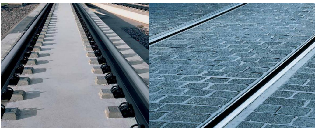
Figura 4: Via em fixação direta – Laje de travamento concretada e aspecto final da via, com revestimento em bloquetes de concreto. Fonte: Railone
