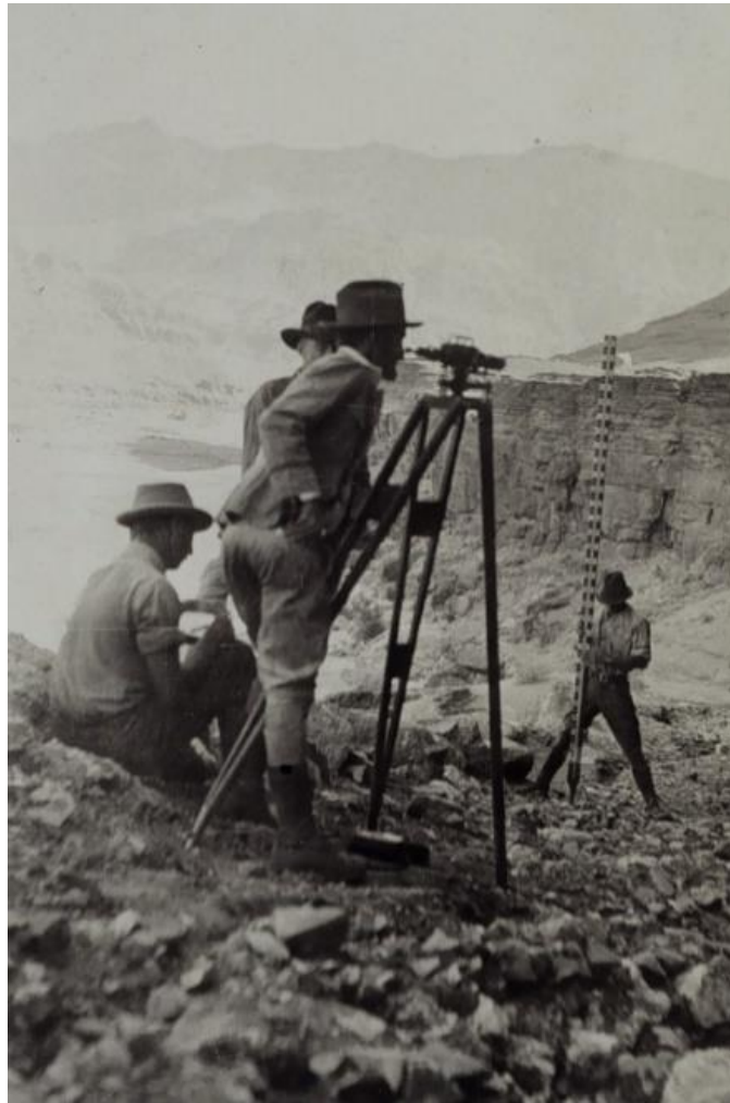
Figura 5.10 – Tripé e Dumpy Level em nivelamento as margens do Rio Hudson em 1856.
