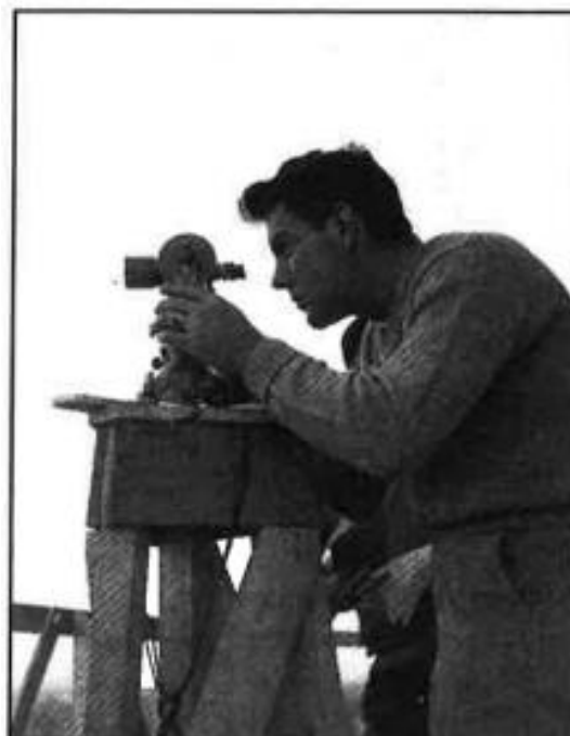
Figura 5.13 – Levantamento com o Teodolito Wild T-3.
