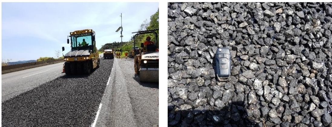
Figura 46 – (a) Compactação da 1ª camada com utilização de rolo pneumático; (b) Textura obtida para a primeira camada (Brita 1)
