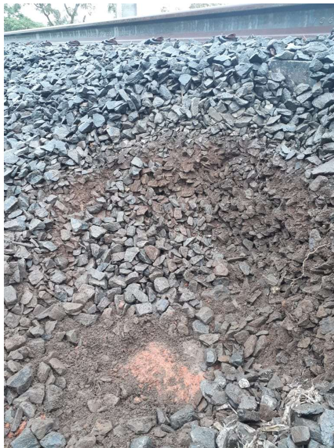
Figura 35 - Camadas do pavimento ferroviário no km 323+600 ZMM-ZMG
