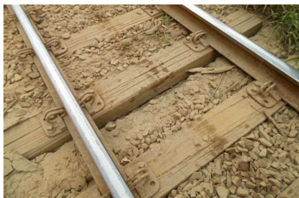
Figura 7 - "GAP" na interface dormente e lastro
