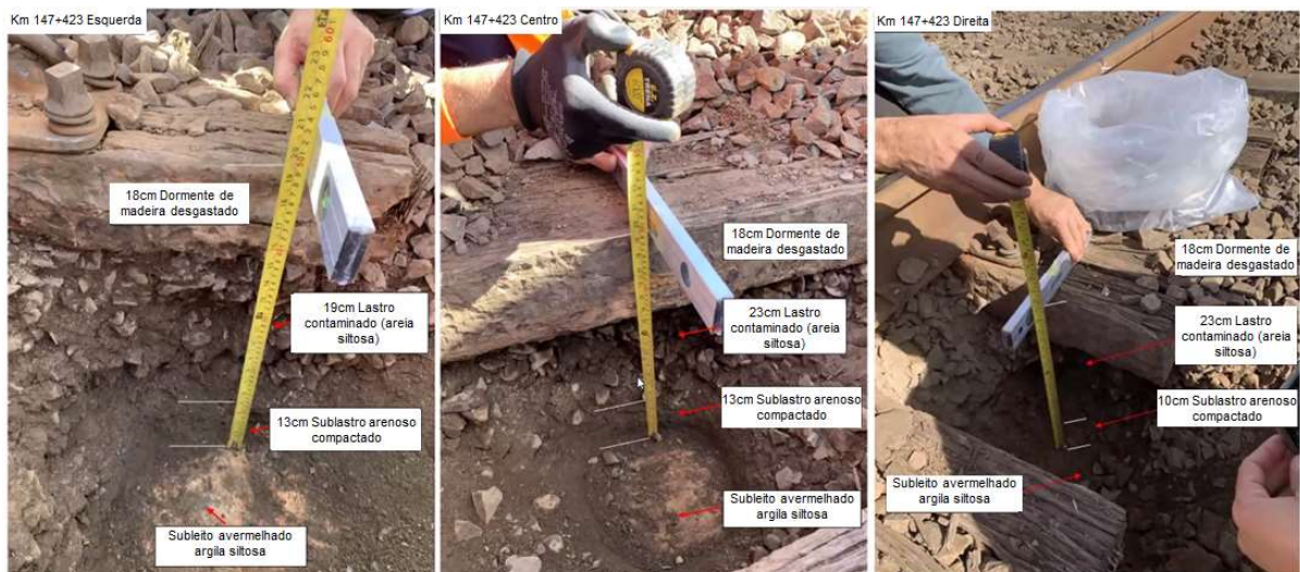
Figura 28 - Exemplo de calibração de altura de camadas
