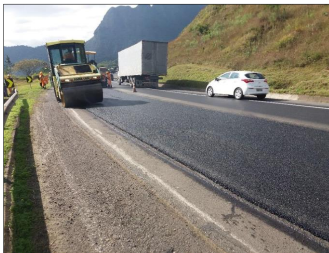
Figura 34 - Execução do trecho experimental norte 1
