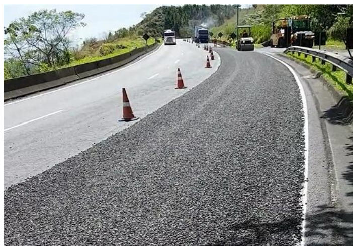
Figura 40 - Execução do trecho experimental sul 1
