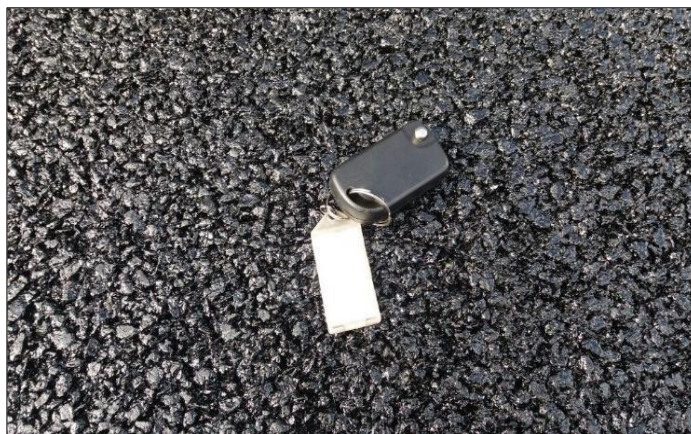
Figura 32 - Textura da mistura asfáltica aplicada em campo.
