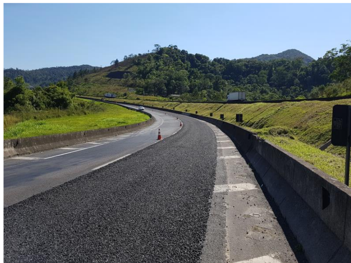
Figura 42 - Execução do trecho experimental sul 2
