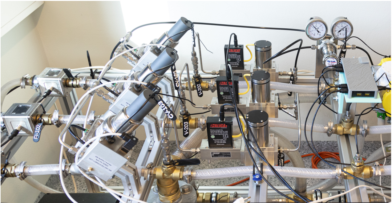
Figura 32 – Foto dos controladores.
