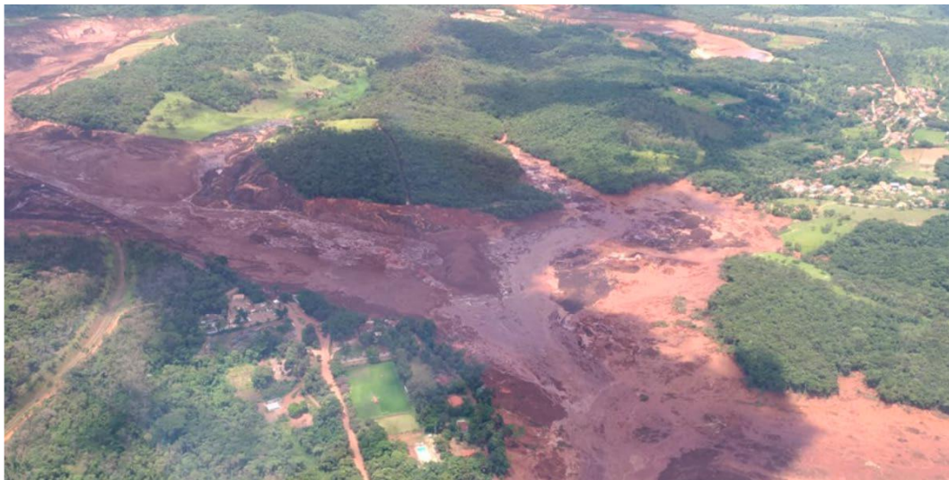
Figura 6 – Desastre ambiental causado pelo rompimento da barragem de Brumadinho-MG (BBC, 2019).
