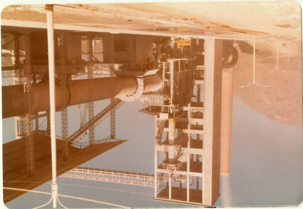
Foto 24 - Vista parcial do forno horizontal, rotativo, tipo Polysius, da Companhia de Cimento Portland Itau, Município de Vespasiano - MG.
