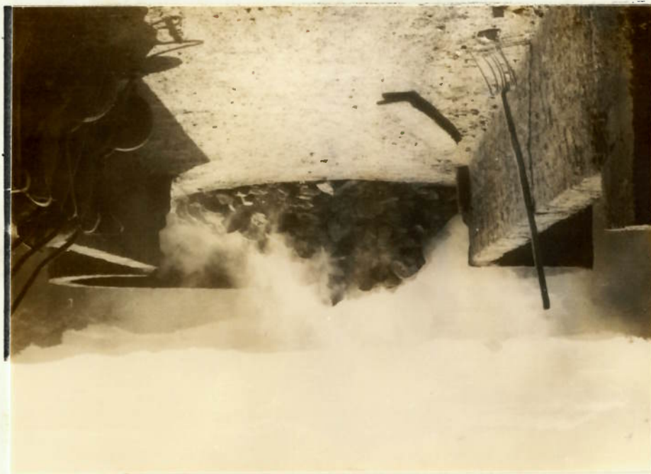
Foto 3 - Vista da boca de carga do forno vertical, descon- tínuo, de alvenaria, sem chaminé, com tiragem natural. Pratacal, Município de Guapiara - SP.
