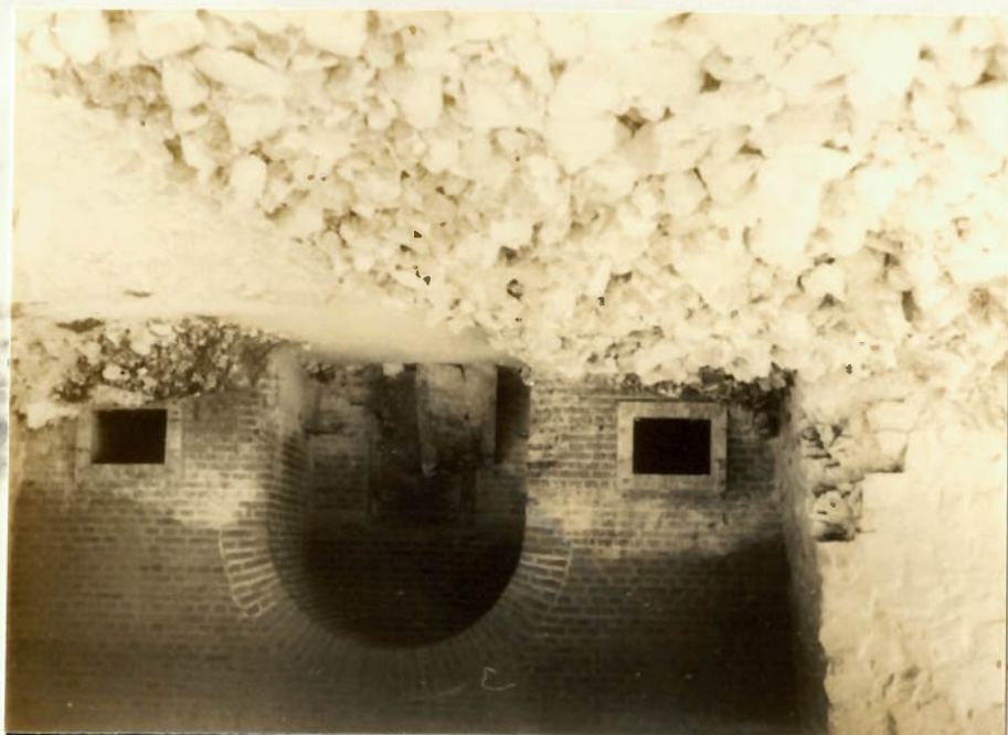
Foto 2 - Detalhe da zona de descarga e a cal em resfriamento. Forno vertical, descontinuo, de alvenaria, Município de Guapiara - SP.
