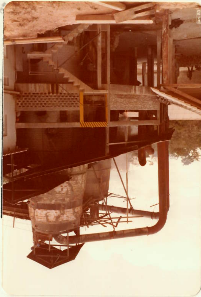
Foto 5 - Vista geral dos fornos verticais, contínuos, de alvenaria, da Companhia de Cimento Portland Itau, Município de Arcos - MG.
