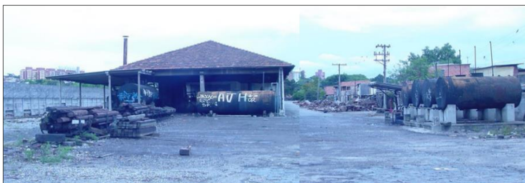
Figura 10 - Foto do ano de 2002 das instalações do setor de tratamento químico de madeiras da antiga UTM Jaguaré após o encerramento de suas atividades
