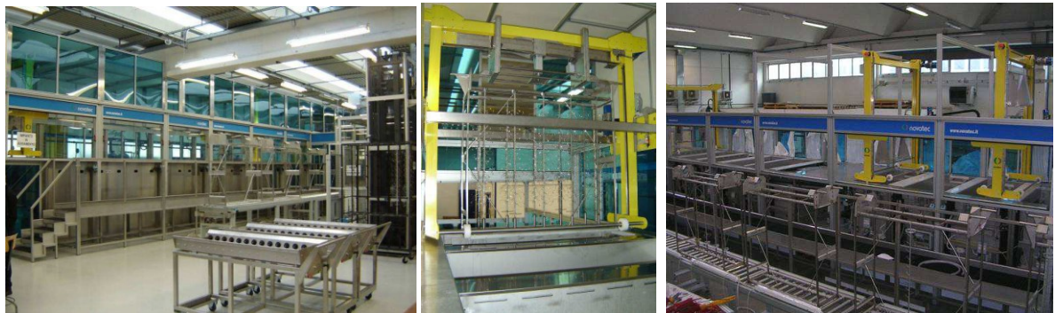
Figura 4 - Linha de pré-tratamento para processos PVD.
