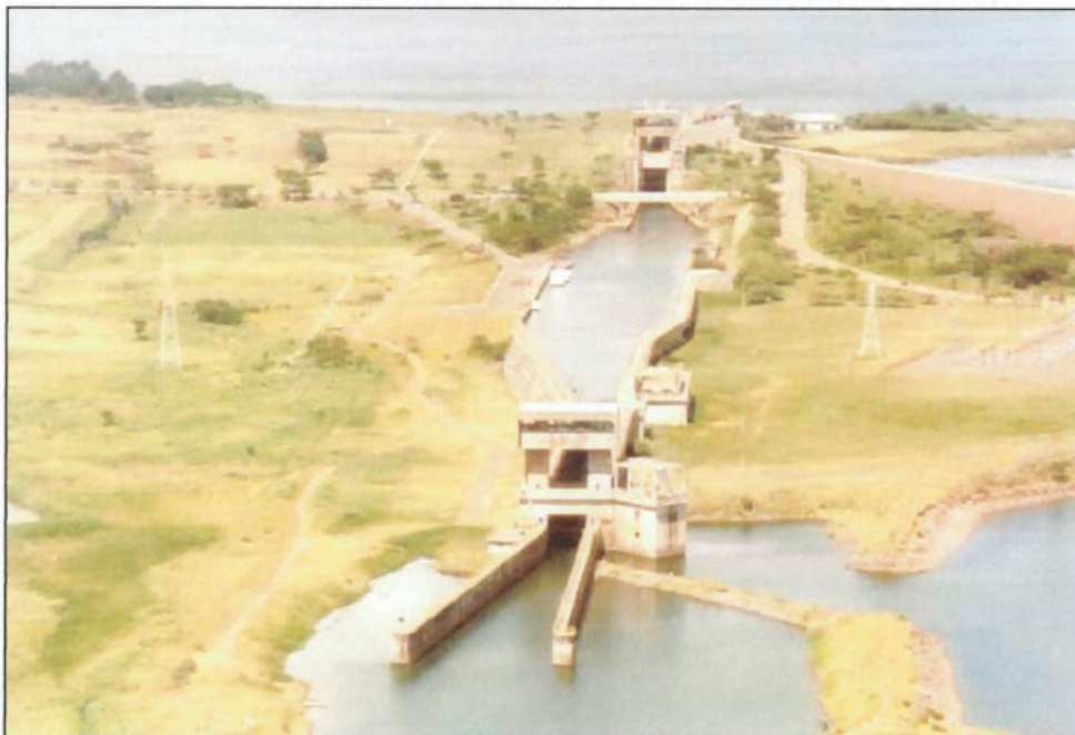
Figura C.5 - Eclusa de Nova Avanhandava – 1991 (Fonte: DH - 2001) [13] (vista da eclusa inferior, canal intermediário e eclusa superior).
