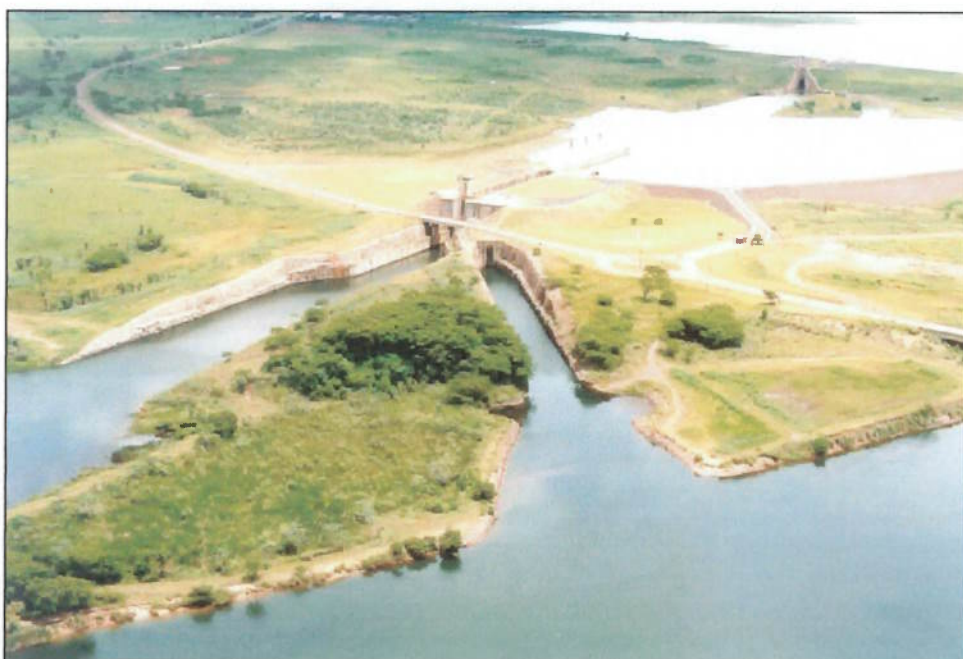
Figura C.6 - Eclusa de Três Irmãos – 1994 (Fonte: DH - 2001) [13] (vista lateral da eclusa inferior, canal intermediário e eclusa superior).
