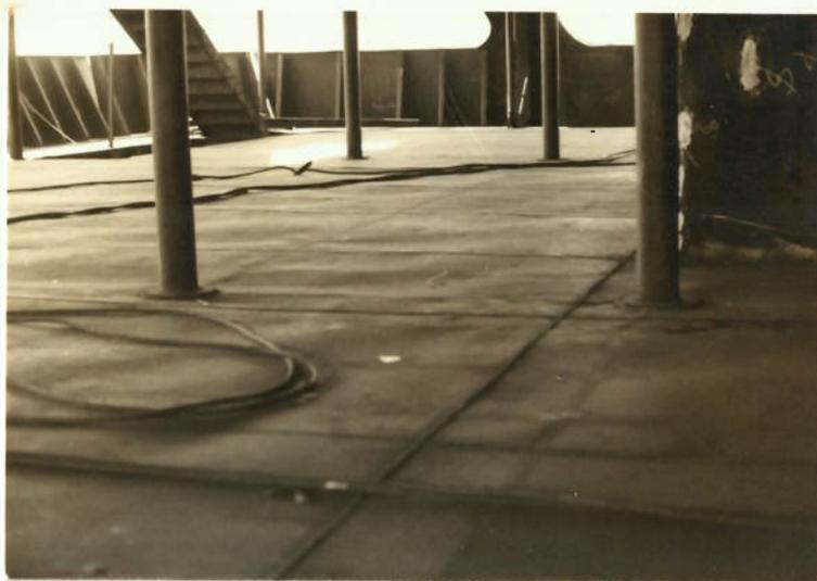
Figura 55 - Piso do convés intermediário (de passageiros) com um chapeamento de espessura 6,35mm
