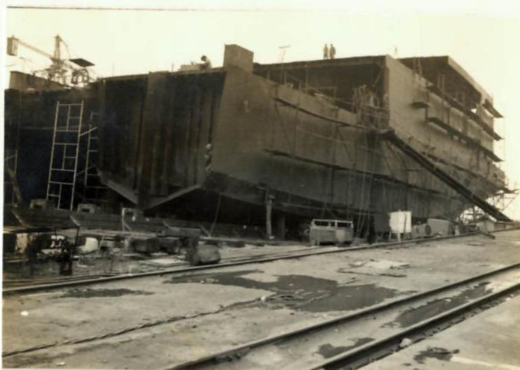
Figura 57 - Montagem dos blocos na carreira
