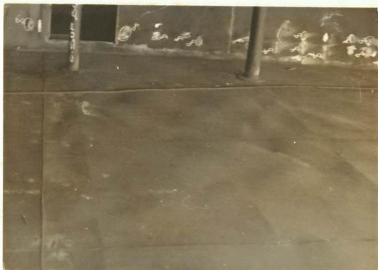
Figura 56 - Piso do convés intermediário próximo à região dos banheiros com um chapeamento de espessura 6,35mm
