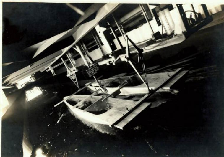
Figura 35 - Ensaio nos calados  $H_{AV}=2,28m$  e  $H_{AR}=3,20m$ (condição de prova de velocidade), na velocidade  $V=11$  nós e com uma distância entre linhas de centro dos cascos de  $b = 14m$
