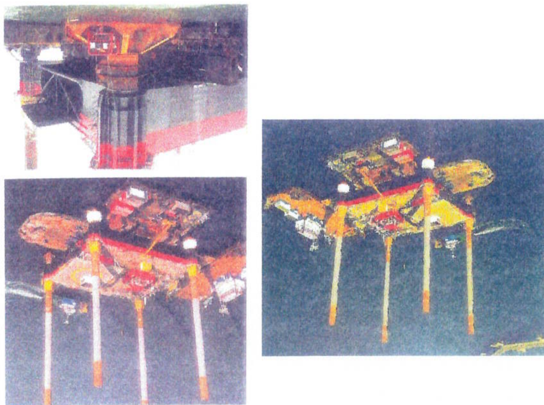
FIGURA 5 – INSTALAÇÃO DE PLATAFORMA SIP II EM ANGOLA - ÁFRICA
