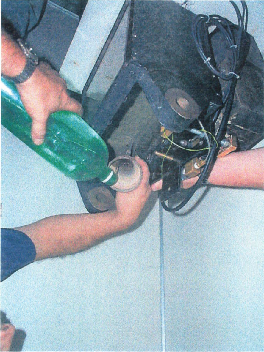
Após a montagem do solo, colocação de água deaerada.
