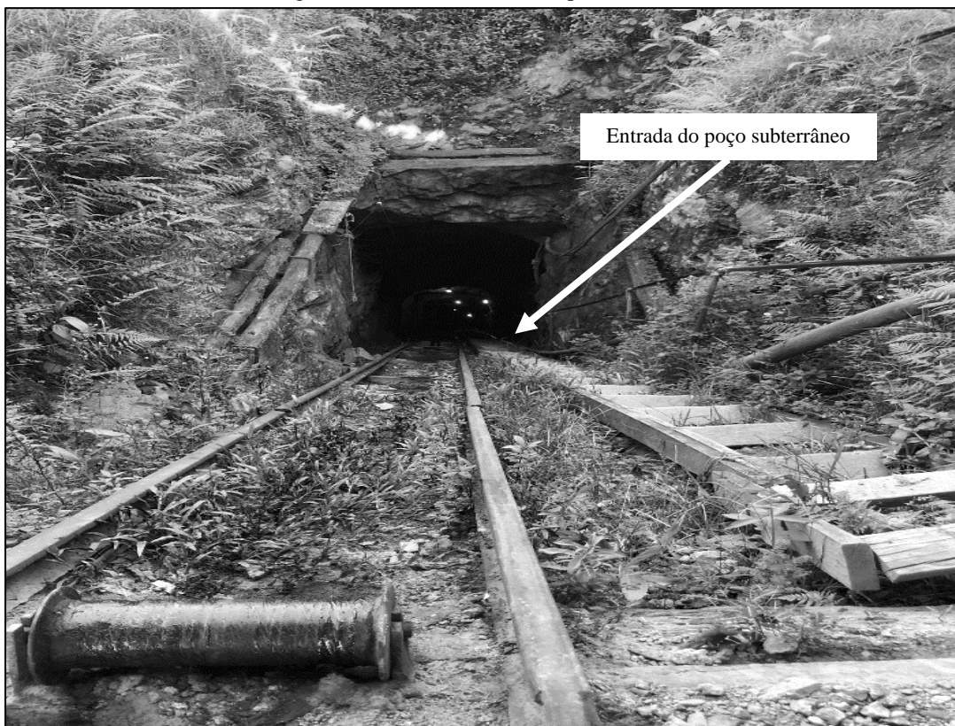
Figura 52 – Frente de trabalho por lavra subterrânea
