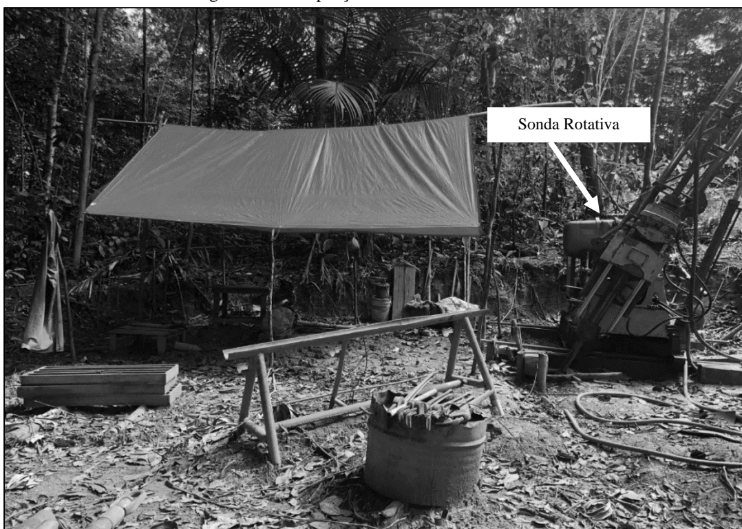
Figura 51 – Prospecção de nova frente de trabalho
