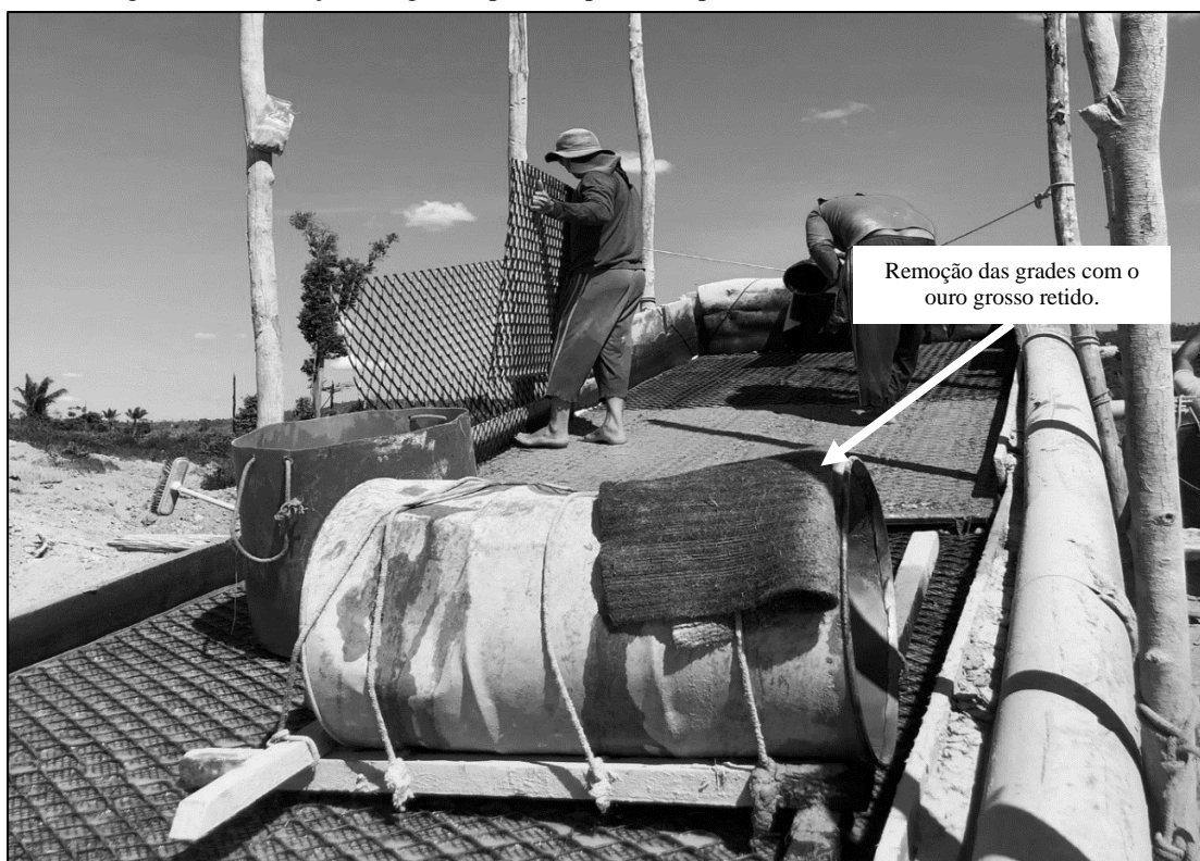
Figura 69 – Remoção das grades para limpar os carpetes, Castelo dos Sonhos, Altamira, Pará
