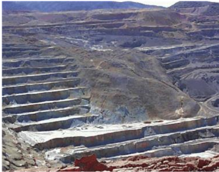
Figura 10: Ruptura de um talude de cava de mineração por mecanismos complexos
