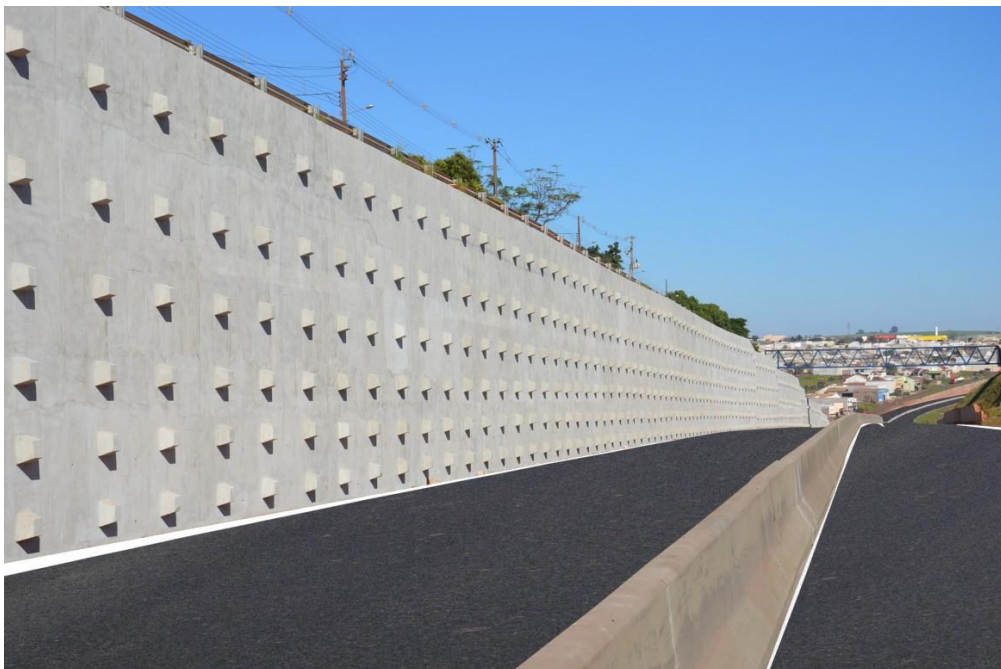
Figura 3: Proteção de talude na estrada Contorno Norte – Maringá, PR
