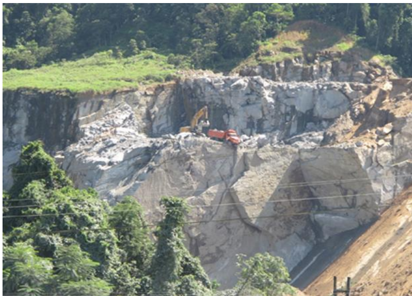
Figura 1: Ruptura da cava da Pedreira Santa Teresa, com detalhe para o caminhão suspenso
