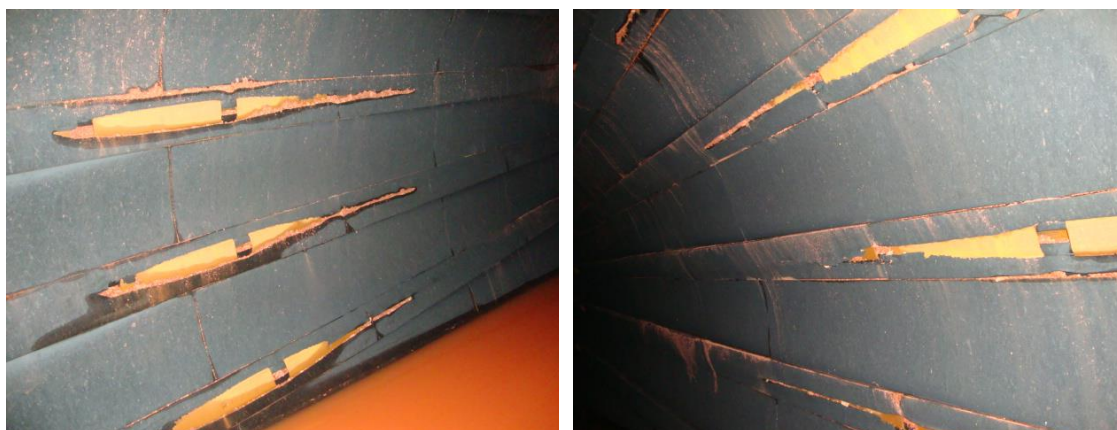
Figura 55 - Revestimento interno do lavador da linha 1.
