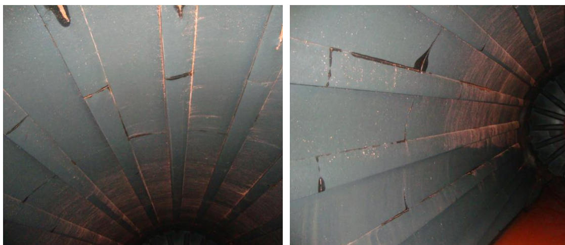
Figura 56 - Revestimento interno do lavador da linha 2.
