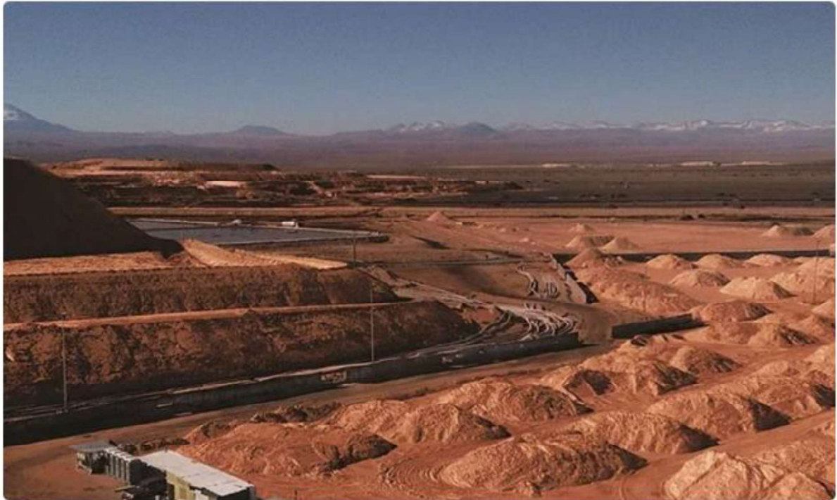
Figura 15. Empilhamento de rejeito a seco
