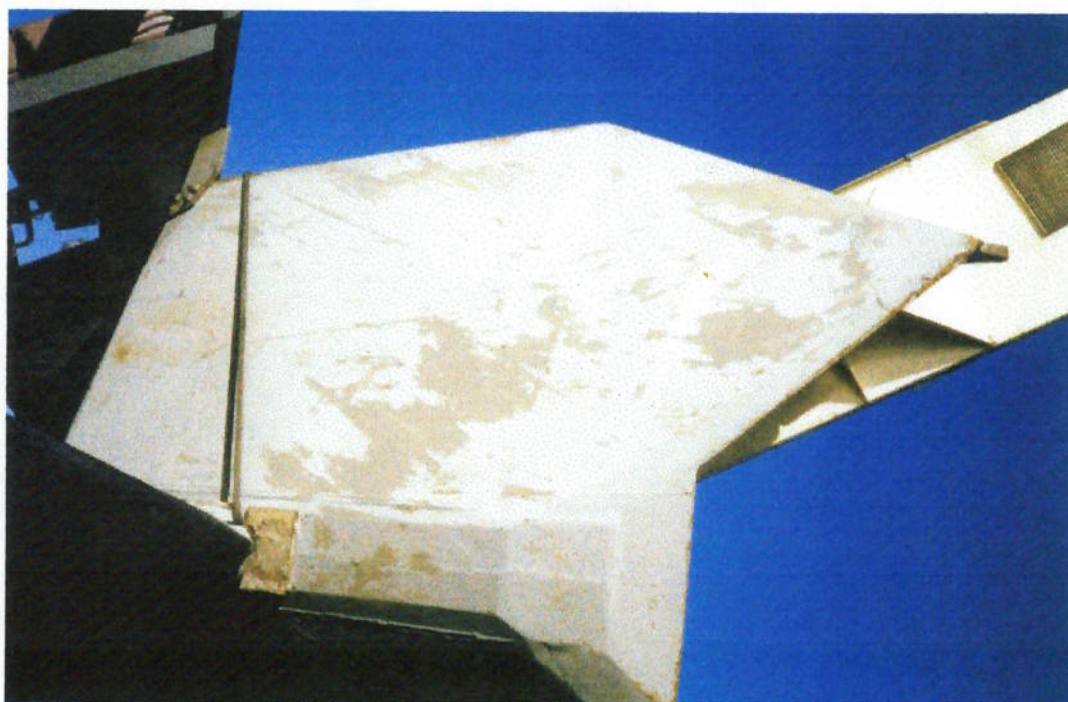
(b) Vista de um trecho superior da pata
