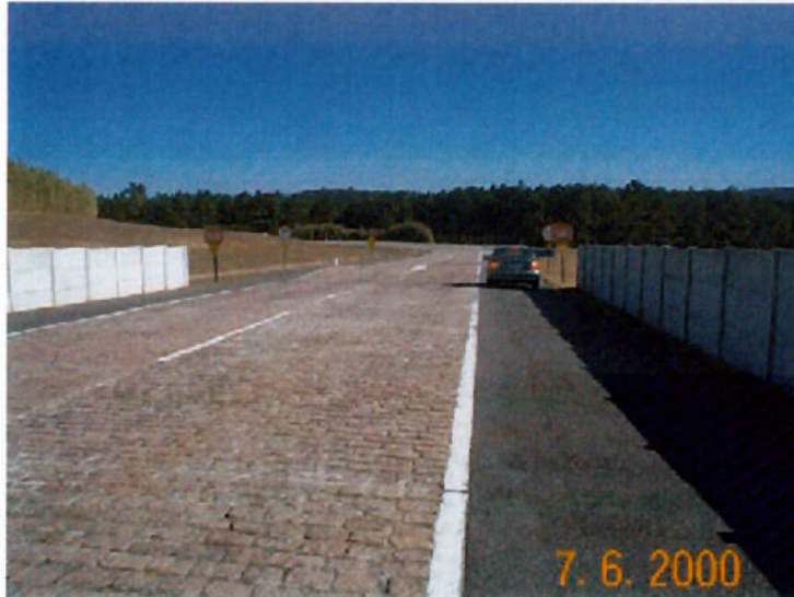
Figura 4.1 – Trecho de Pista de Paralelepípedos Utilizado na Simulação de Aspereza
