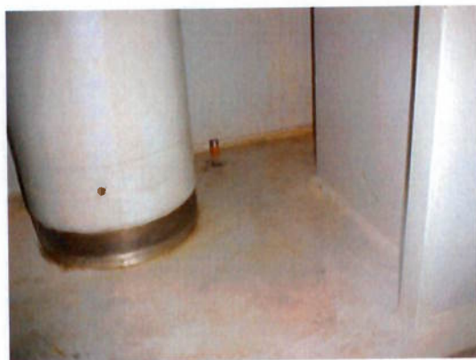
Fig. 6.8 Tubo soldado na tampa externa (em vermelho).
