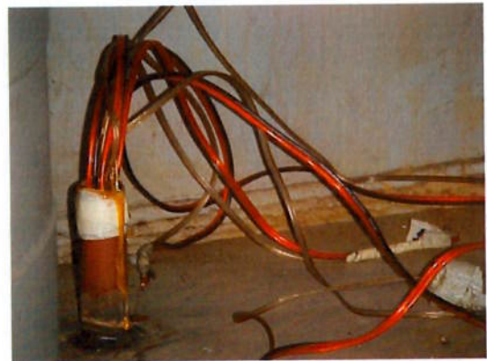
Fig. 6.17 Tubo com resina e cabos identificados.
