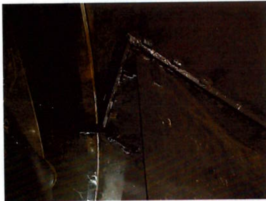
Fig. 6.16 Cobertura com Devcon (antes do lixamento).
