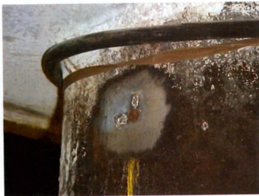
Fig. 6.4 Extensômetros colados na travessa.
