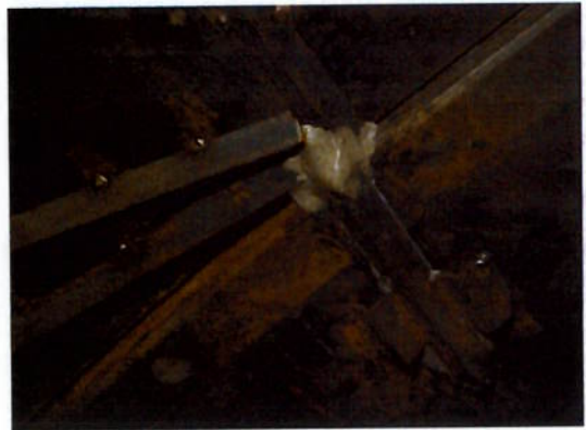
Fig. 6.15 Acabamento na junção das cantoneiras ( Durepoxi ).
