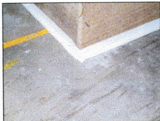
Fig.5.10: Detalhe da vedação com a fita adesiva. Fig.5.11: Trecho descoberto.
