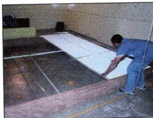
Fig.5.7: Disposição dos painéis.
