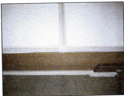
Fig. 5.14: Vedação com a fita adesiva.
