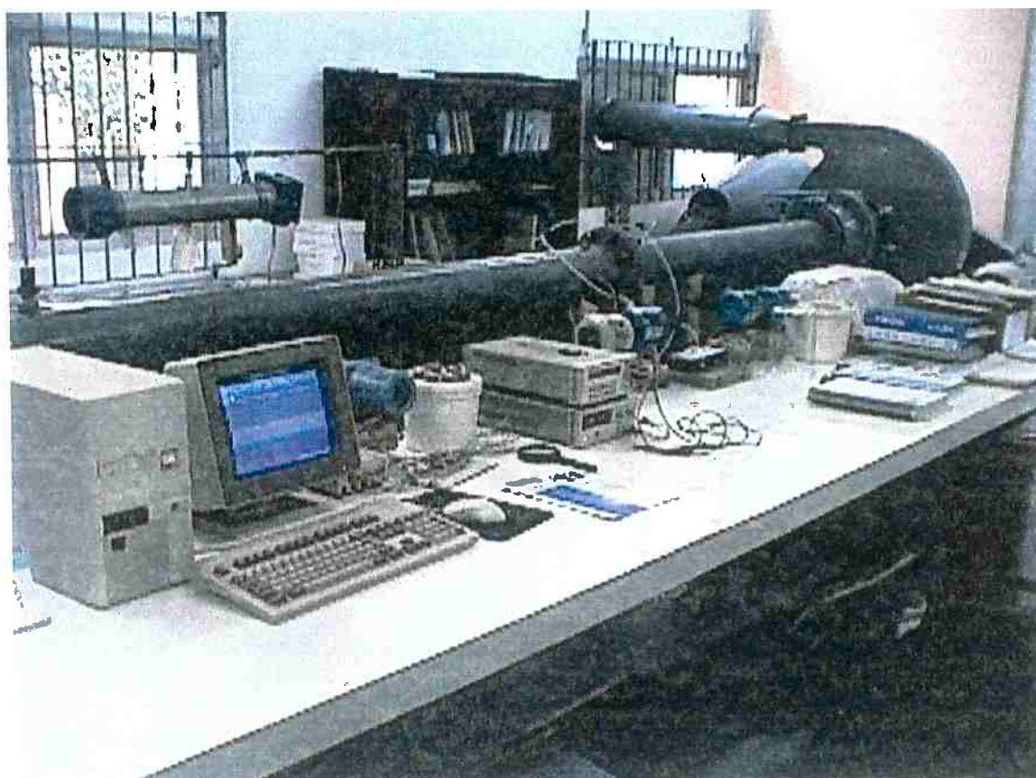
Figura 7.11 – Vista geral da instrumentação e da tubulação onde é medida a vazão de ar.
