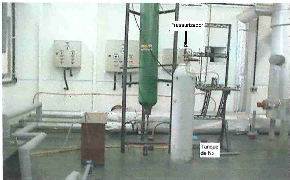
Figura 6.6 Acumulador hidro-pneumático utilizado para aumentar a pressão do fluido.
