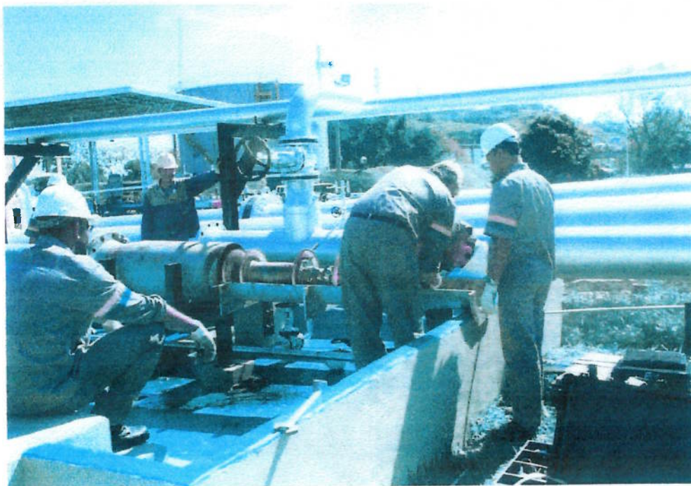
Figura 4.55 – Pig sendo inserido na tubulação de testes da Petrobrás (Duque de Caxias – RJ) pela equipe do Sr. Cláudio Camerini.
