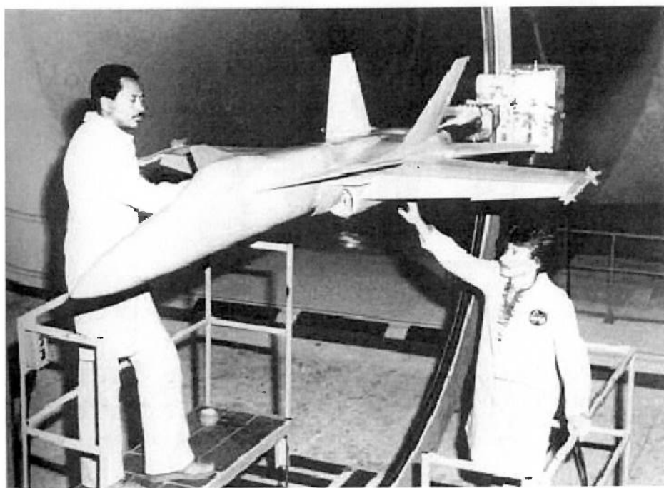
Figura 2.8 : F-18 na NASA. Modelo montado com sting para altos ângulos de ataque (LOW-SPEED WIND TUNNEL TESTING, 1984).
