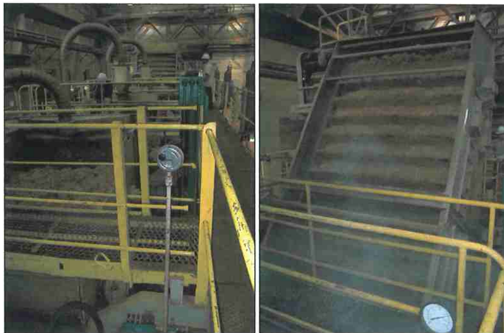
Figura B.5 – Vista dos seis ternos de moendas da Usina Iracema e o bagaço saindo da última moenda
