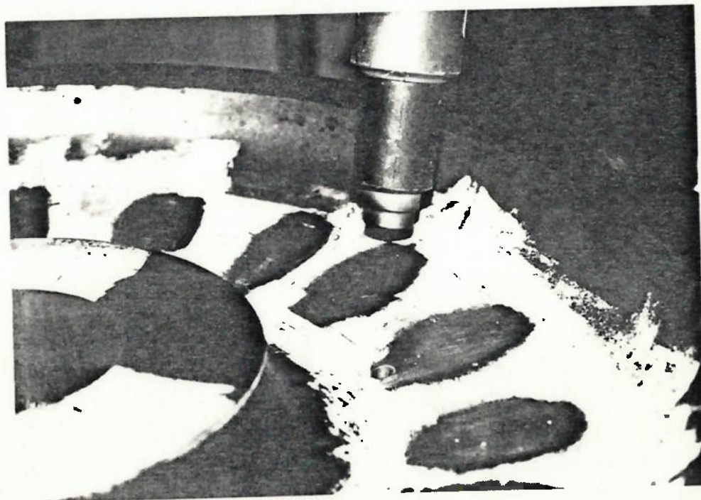
FOTO 2 - Preparação da Superfície para colagem do Extensômetro
