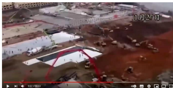
Imagem 55 – Construção de hospital emergencial especializado
