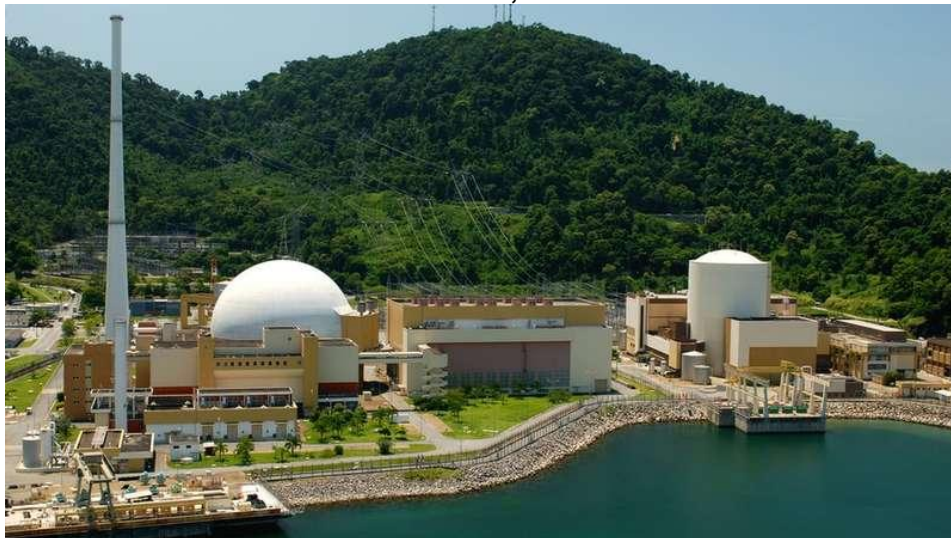
FIGURA 35– USINA NUCLEAR ANGRA I, RIO DE JANEIRO
