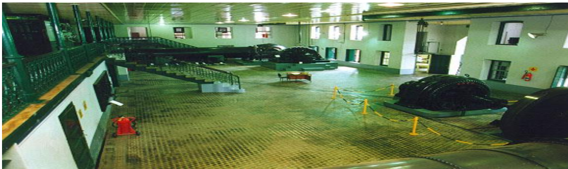
FIGURA 32 - USINA HIDRELÉTRICA CORUMBATAÍ – RIO CLARO – SP (1895)
