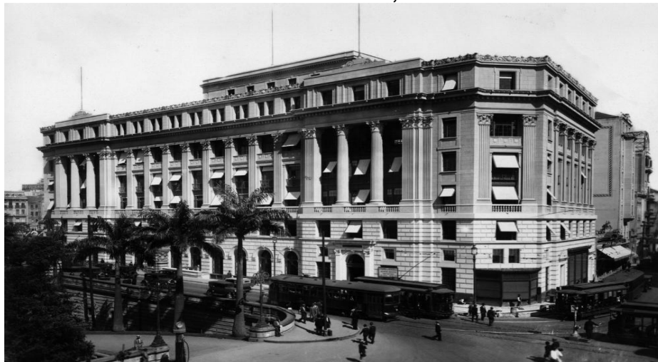
FIGURA 33 – SEDE DA LIGHT AND POWER, SÃO PAULO
