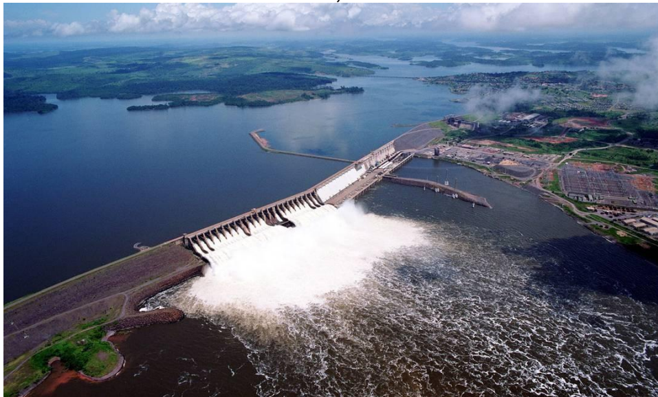
FIGURA 36– HIDRELÉTRICA TUCURUÍ, PARÁ
