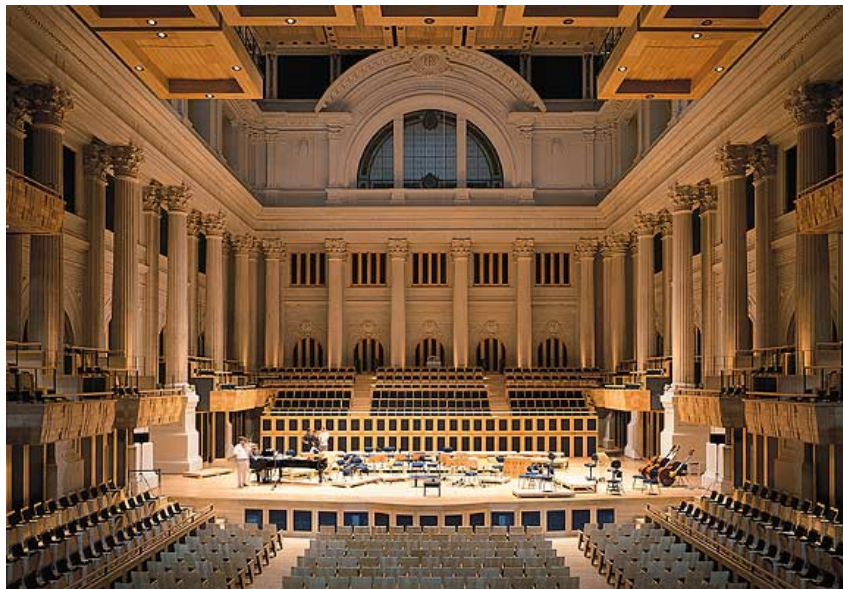
Figura 6 - Sala São Paulo após a reforma
