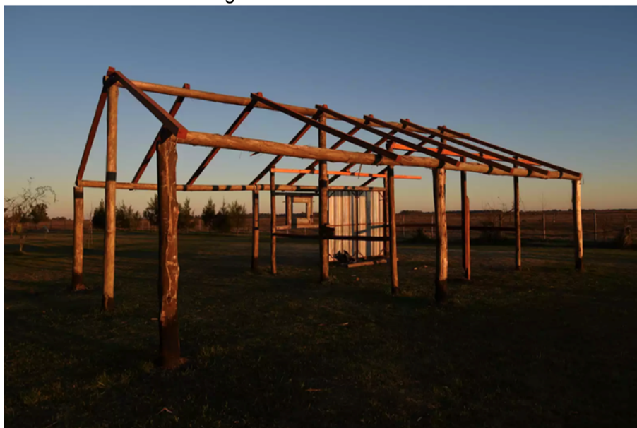
Figura 12 – Obra La Tarea
